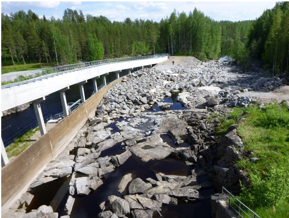
Kuva 6. Hietaman voimalaitospadon ohijuoksutuskanava 11.6.2021 padon päältä kuvattuna. Vasemmalla Hietaman kalatien yläosan nousuosuutta. Kuva: Petri Karppinen
