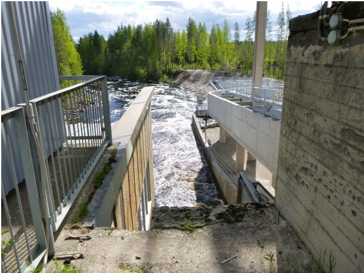
Kuva 4. Leuhun voimalaitoksen ohjuoksutusvedet purkautuvat voimalaitoksen (vasemmalla) ja alakanavan seinämän (oikealla alhaalla) väliin alakanavassa. Ohjuoksutusluukku sijaitsee suunnilleen suoraan kuvaajan alapuolella. Oikealla ylhäällä näkyy kalatien yläosaa. Kuva: Petri Karppinen.
