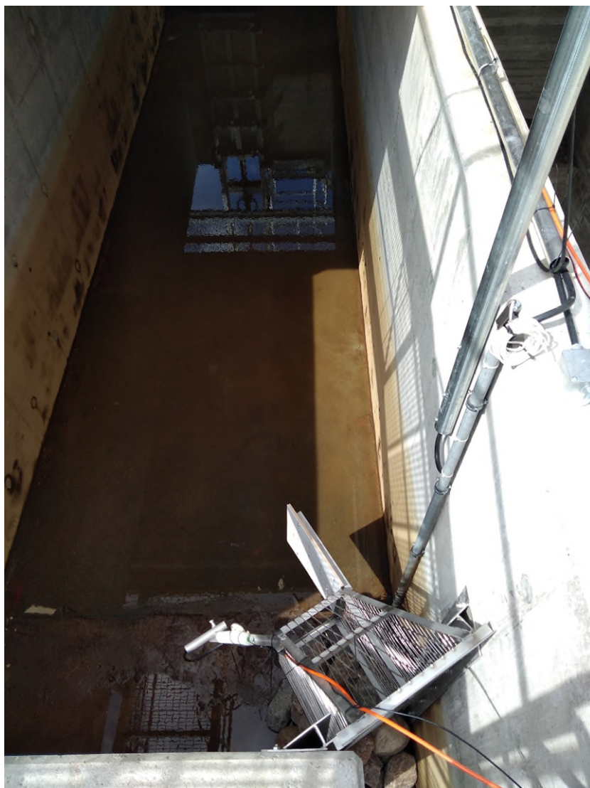
Kuva 3. Hietaman kalatien yläallas ja kalojen seurantapaikka (ohjauskehikko, valo, kamera ja valkolevy).
